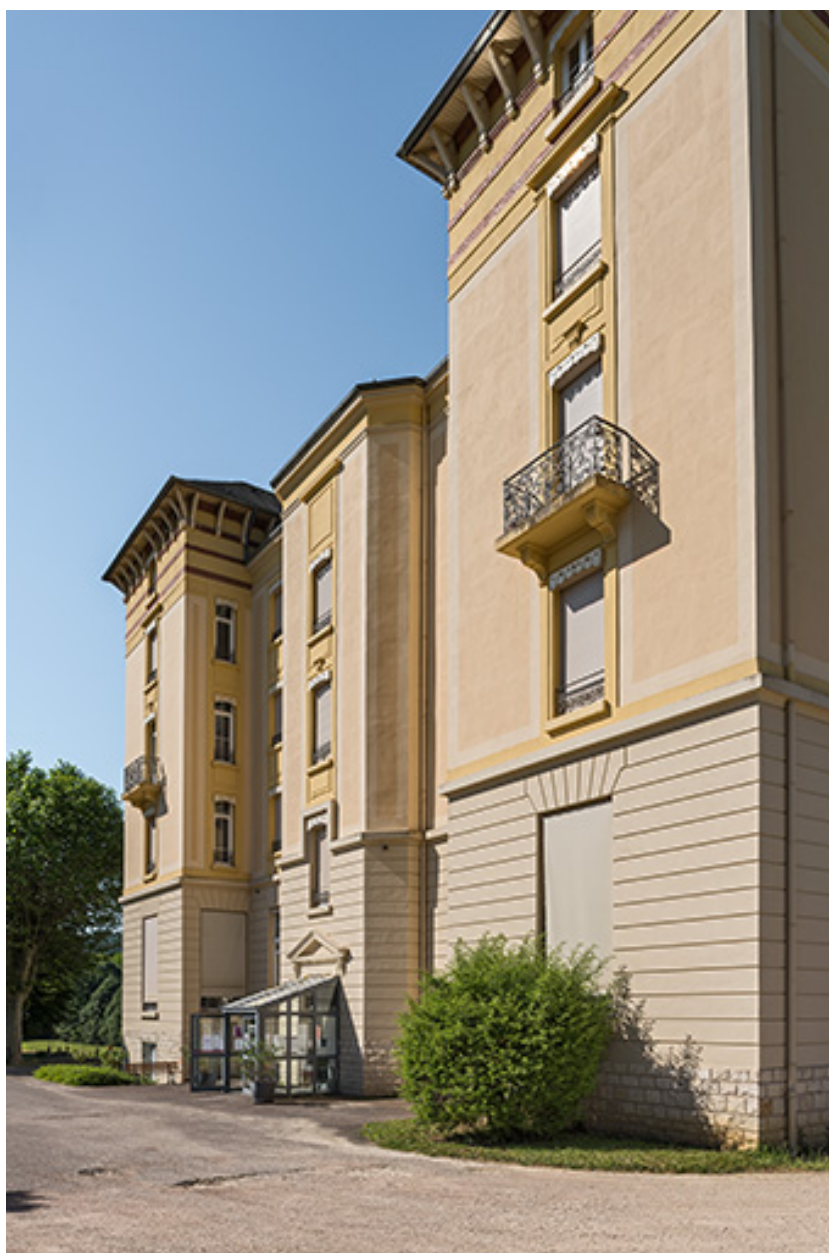
Façade nord-est avec l'entrée de l'escalier.
