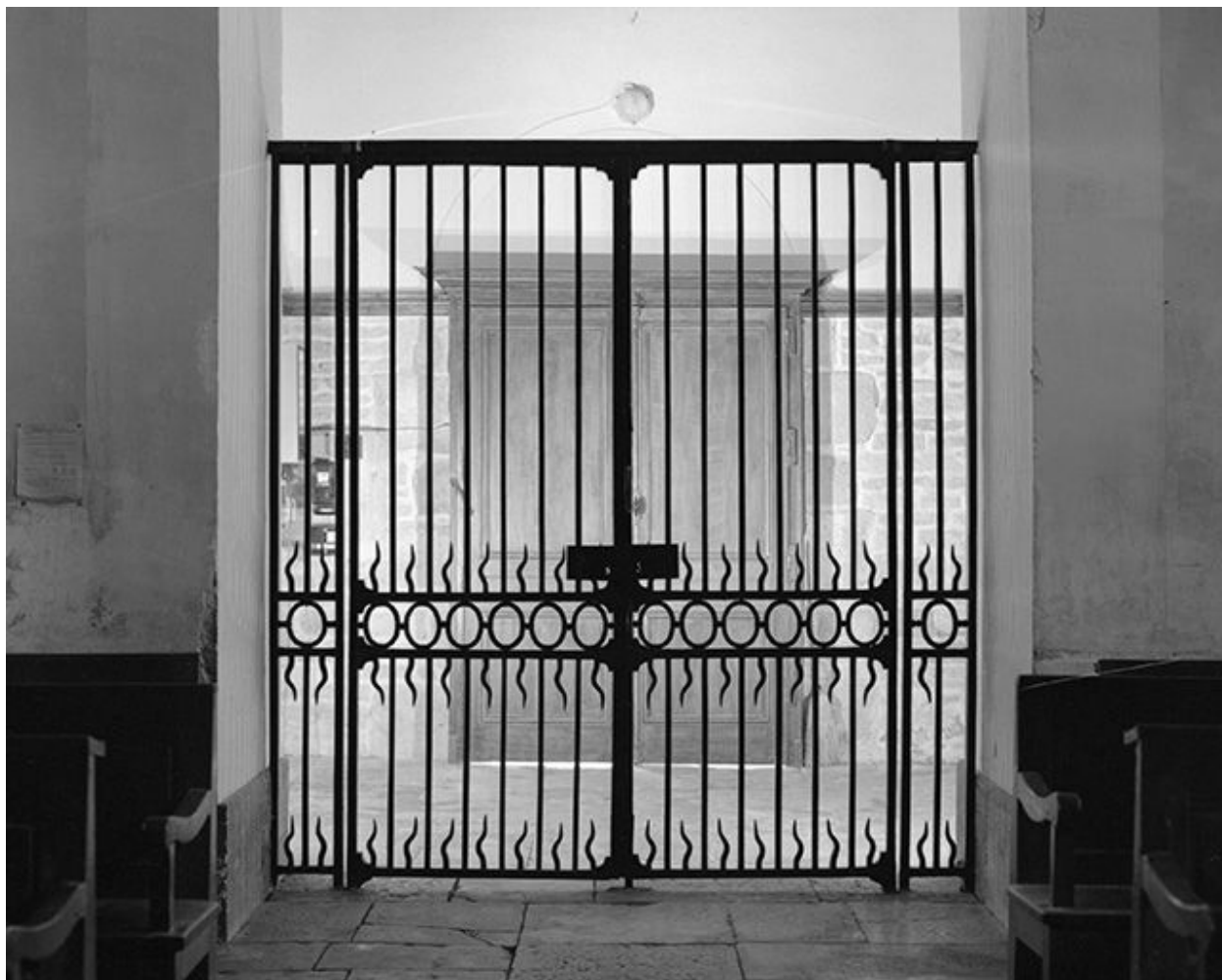
Clôture de chapelle : vue d'ensemble.
