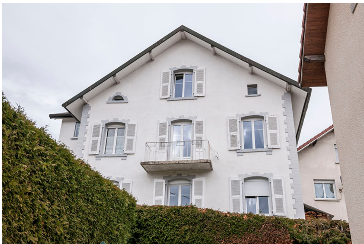
Façade latérale droite, vue en contre-plongée.
