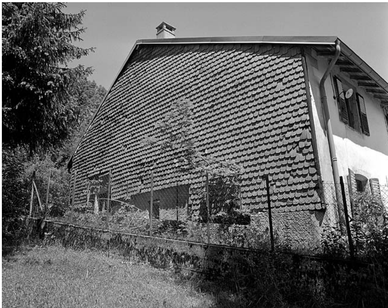
Essentage de tuiles sur un pignon sud-ouest.
