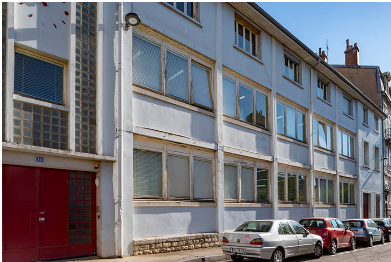
Façade ouest vue de trois quarts gauche.
