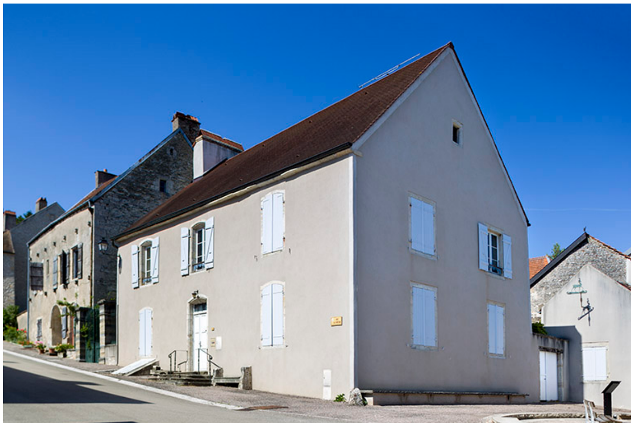
Vue générale de trois quart droite.
