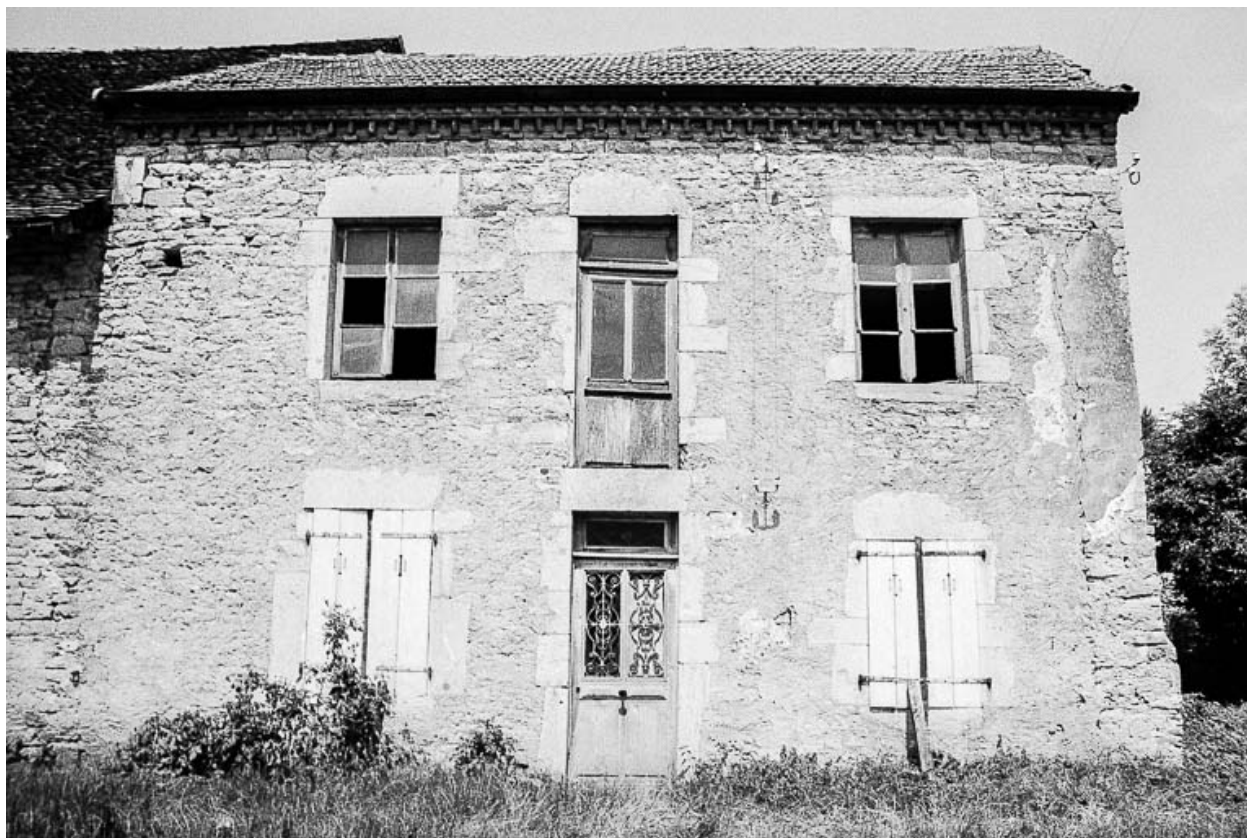
Maisons située 64 rue du Bas d'Oisenans : façade antérieure
