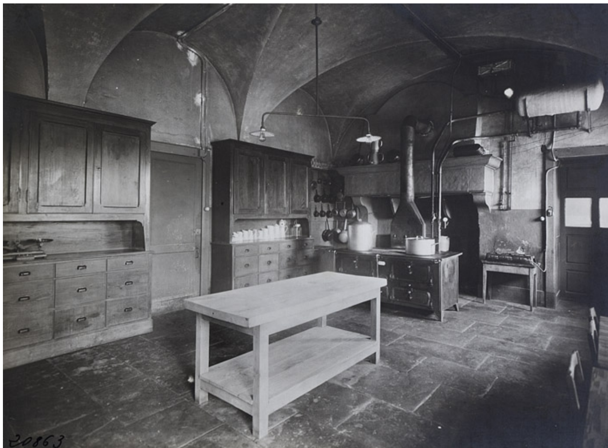
Photographie ancienne montrant la cuisine. Photographie ancienne, 1e moitié 20e siècle.
