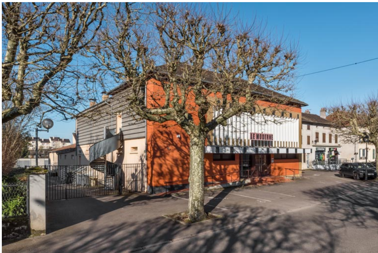
Vue d'ensemble, depuis l'avenue au sud-est.
