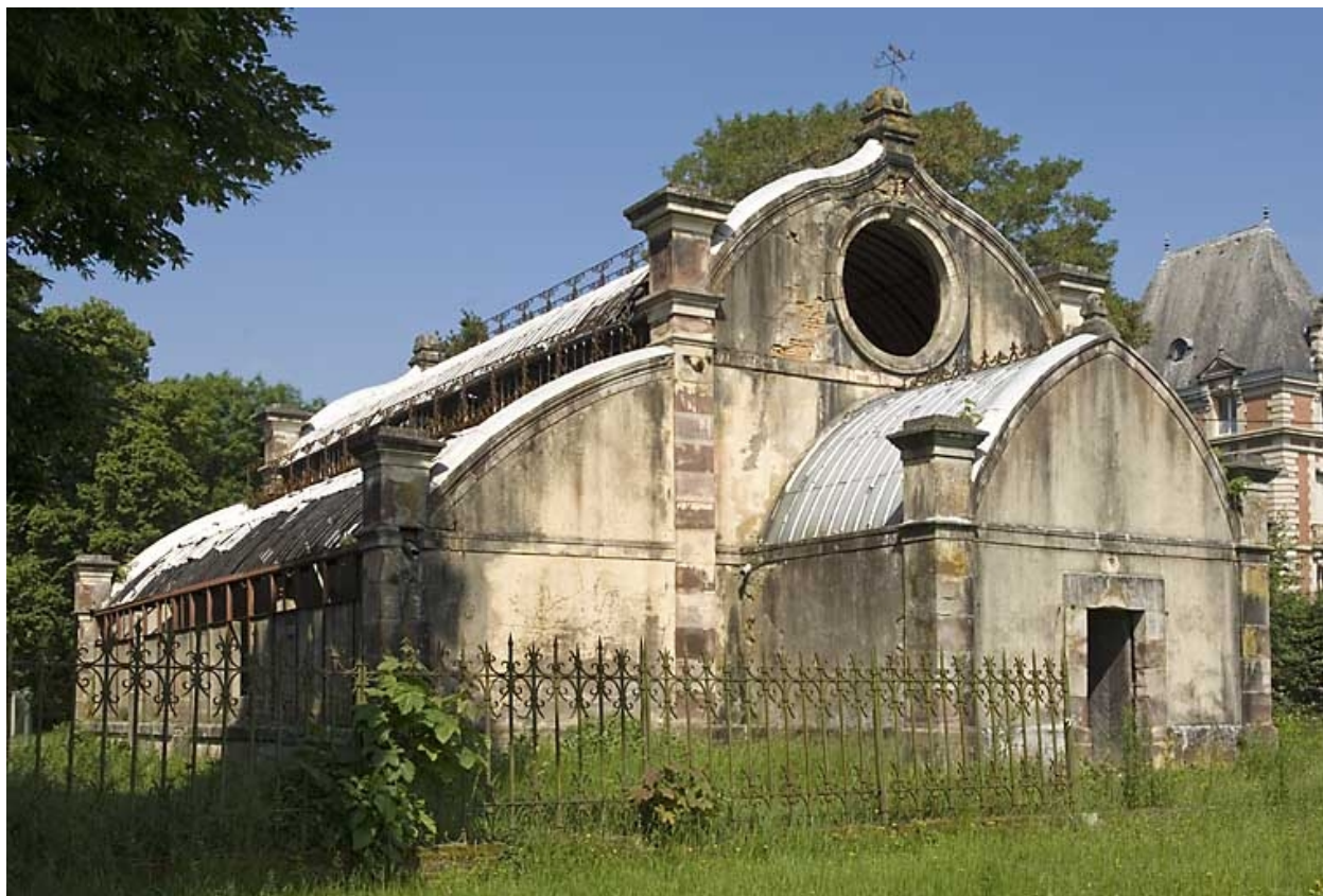
Serre. Vue depuis le sud-est.
