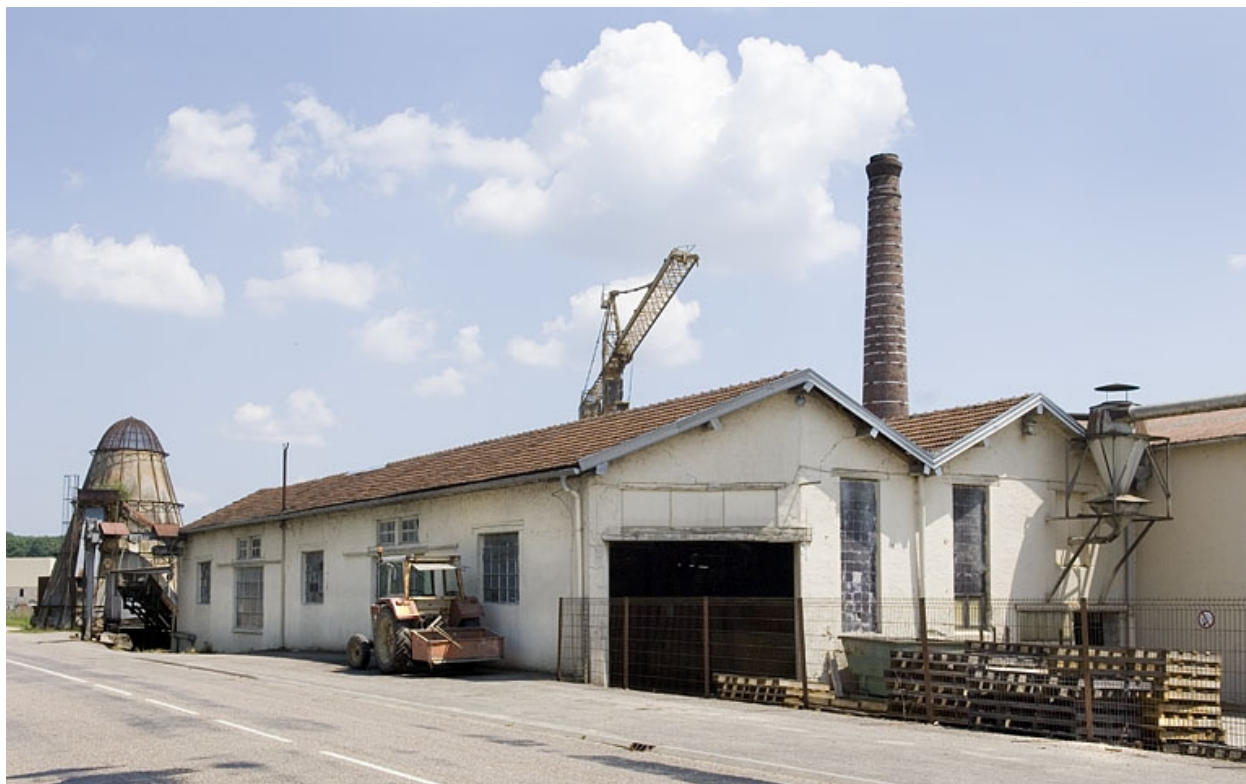
Atelier de fabrication (scie à ruban).
