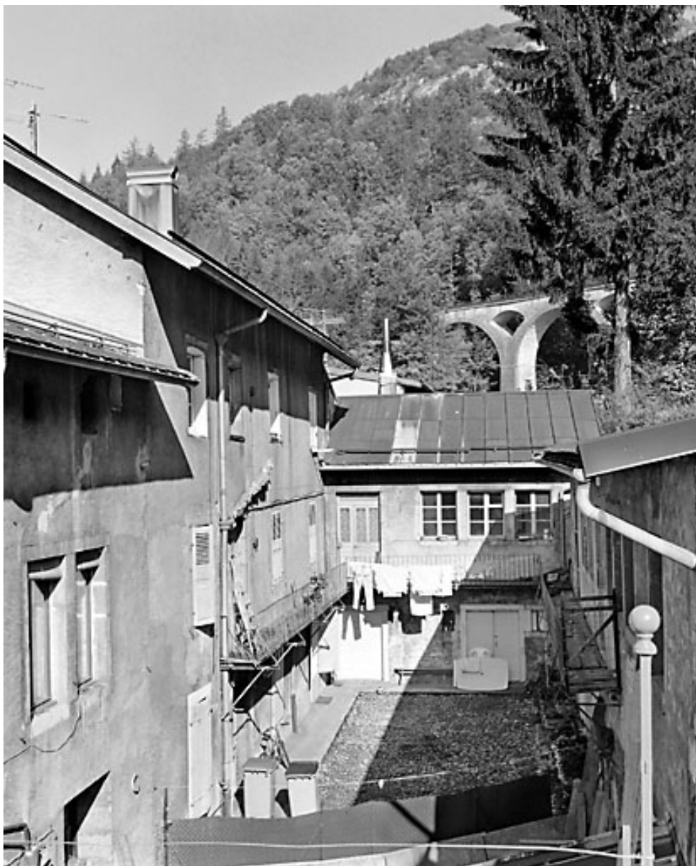
Façade postérieure, vue en enfilade.
