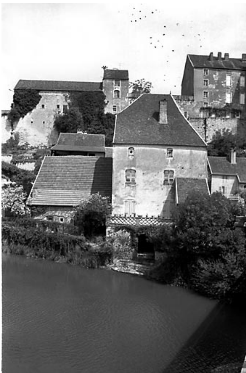
Façades donnant sur l'Ognon.
