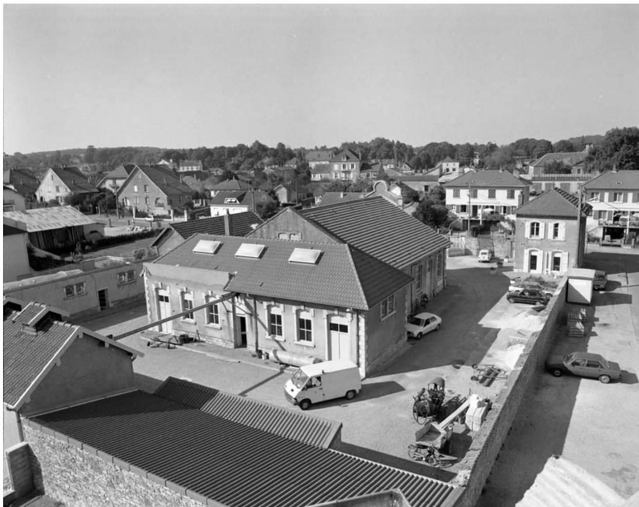
Vue d'ensemble du quartier de l'abattoir.
