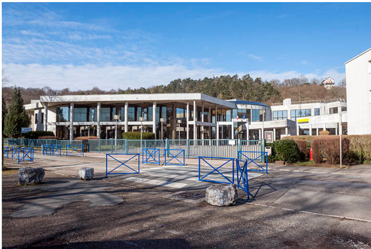
Vue de l'entrée depuis la rue des carrières.
