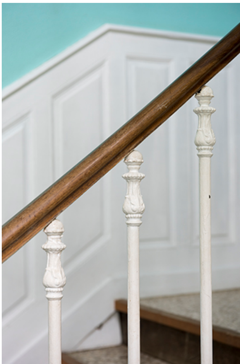
Détail de la rambarde et du garde-corps.
