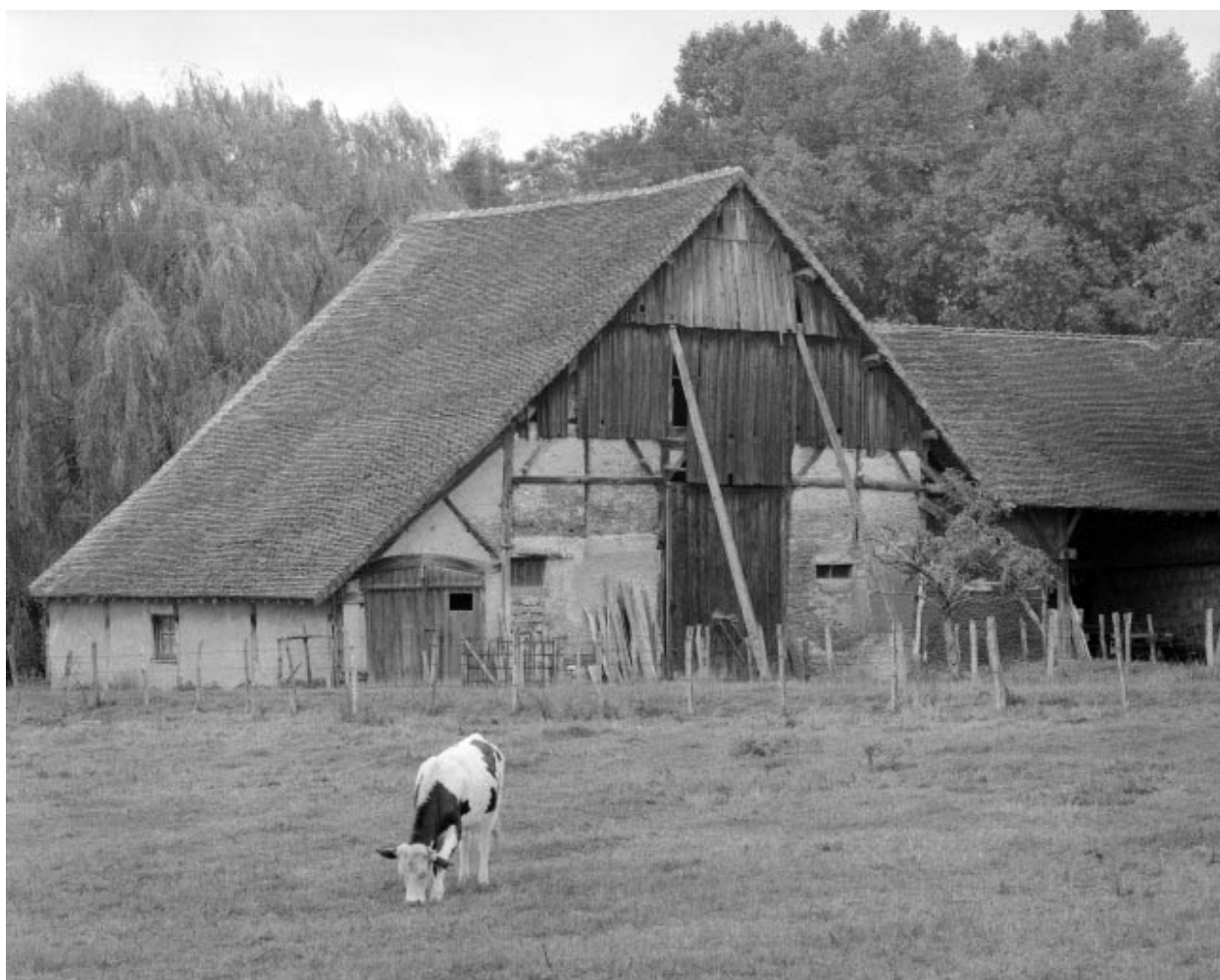
Remise, écurie et fenil depuis le sud-est.
