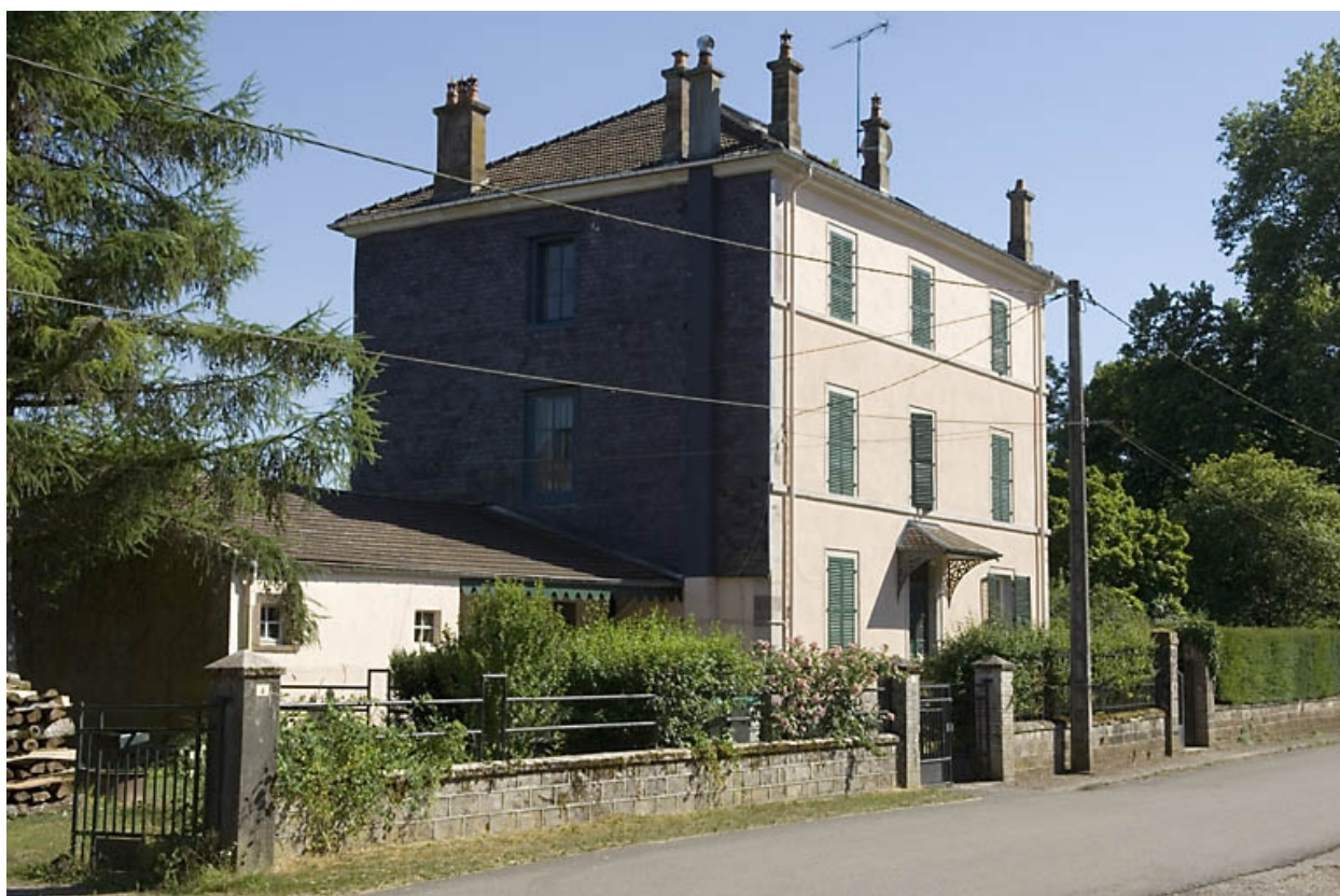
Logement patronal sud. Vue de trois quarts.
