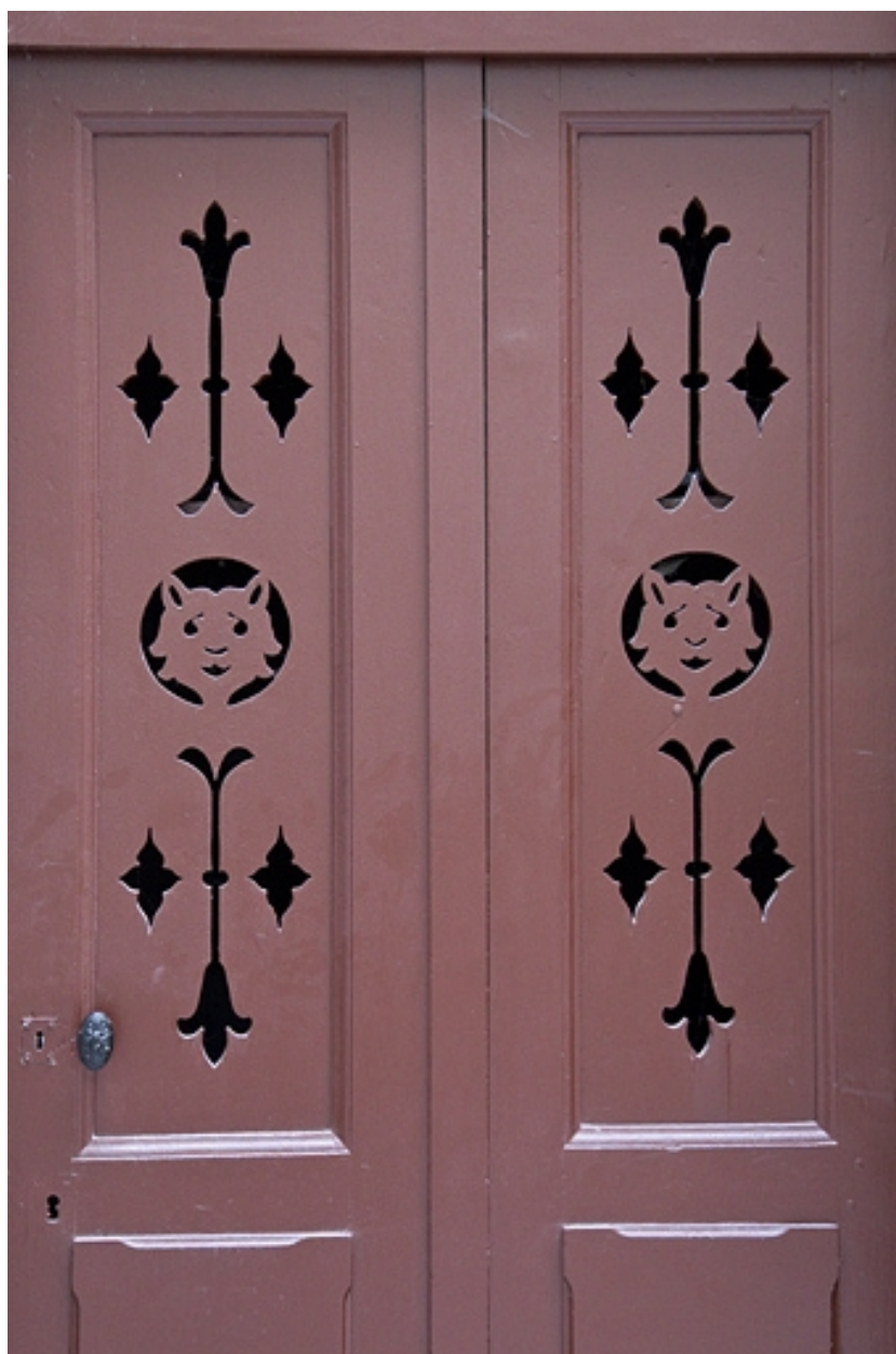
Bûcher : vue d'ensemble de la porte.
