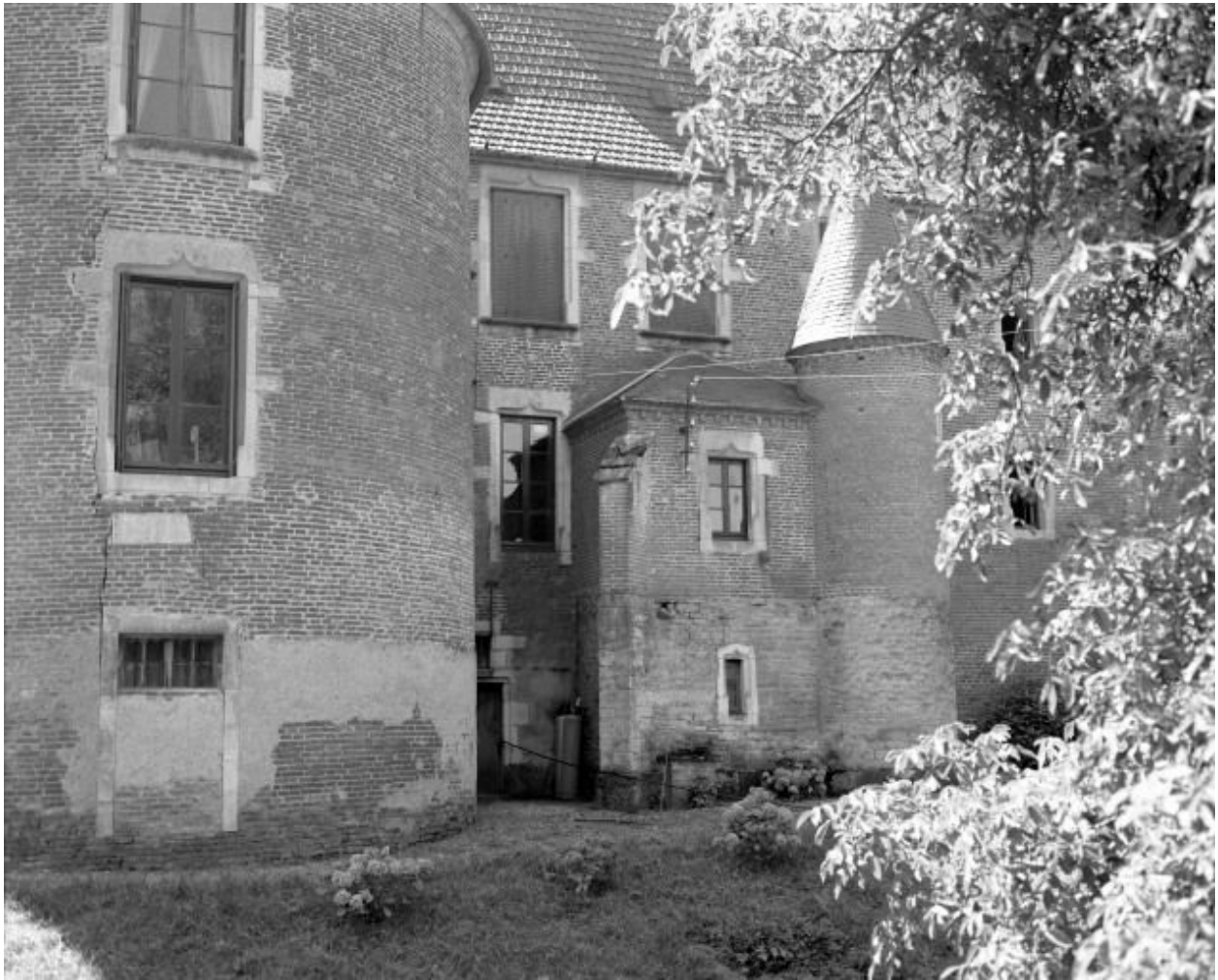
Elévation postérieure, détail.
