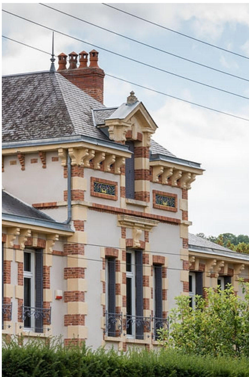
Avant-corps central de la façade principale, détail.
