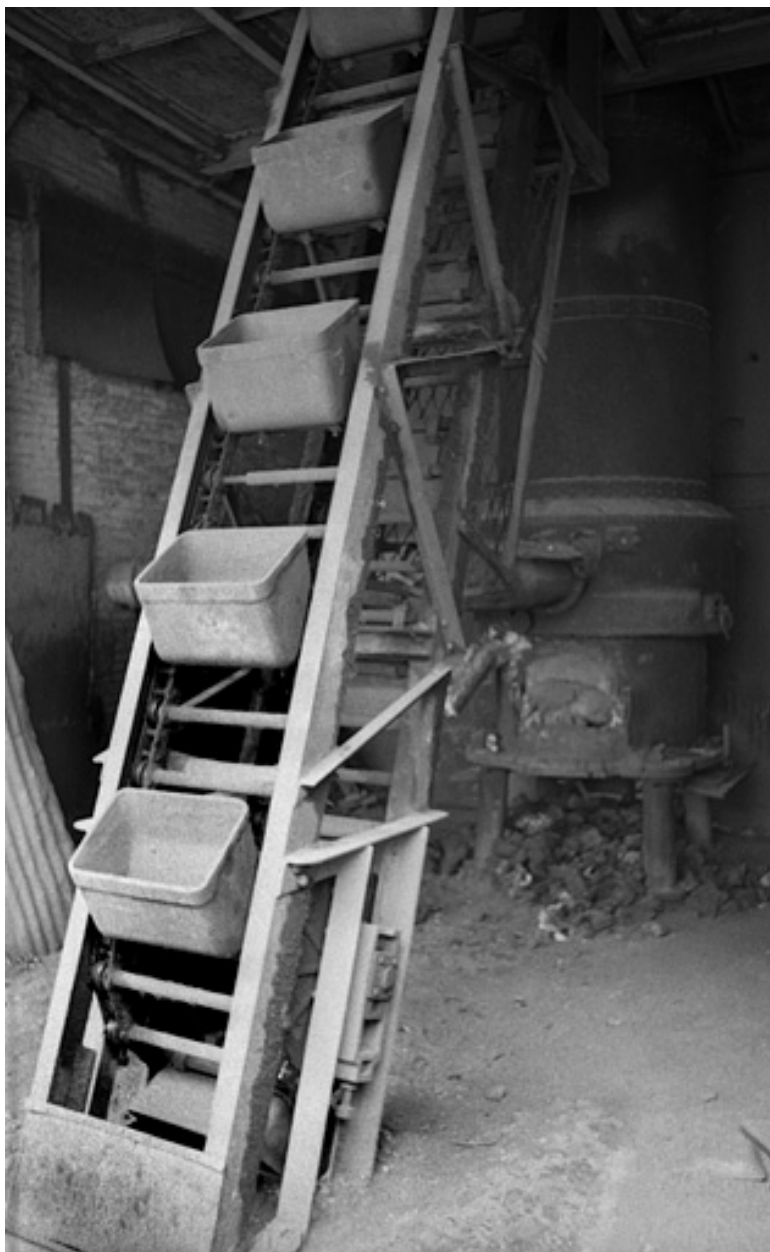
Chargeur à godets du grand cubilot (5 tonnes).
