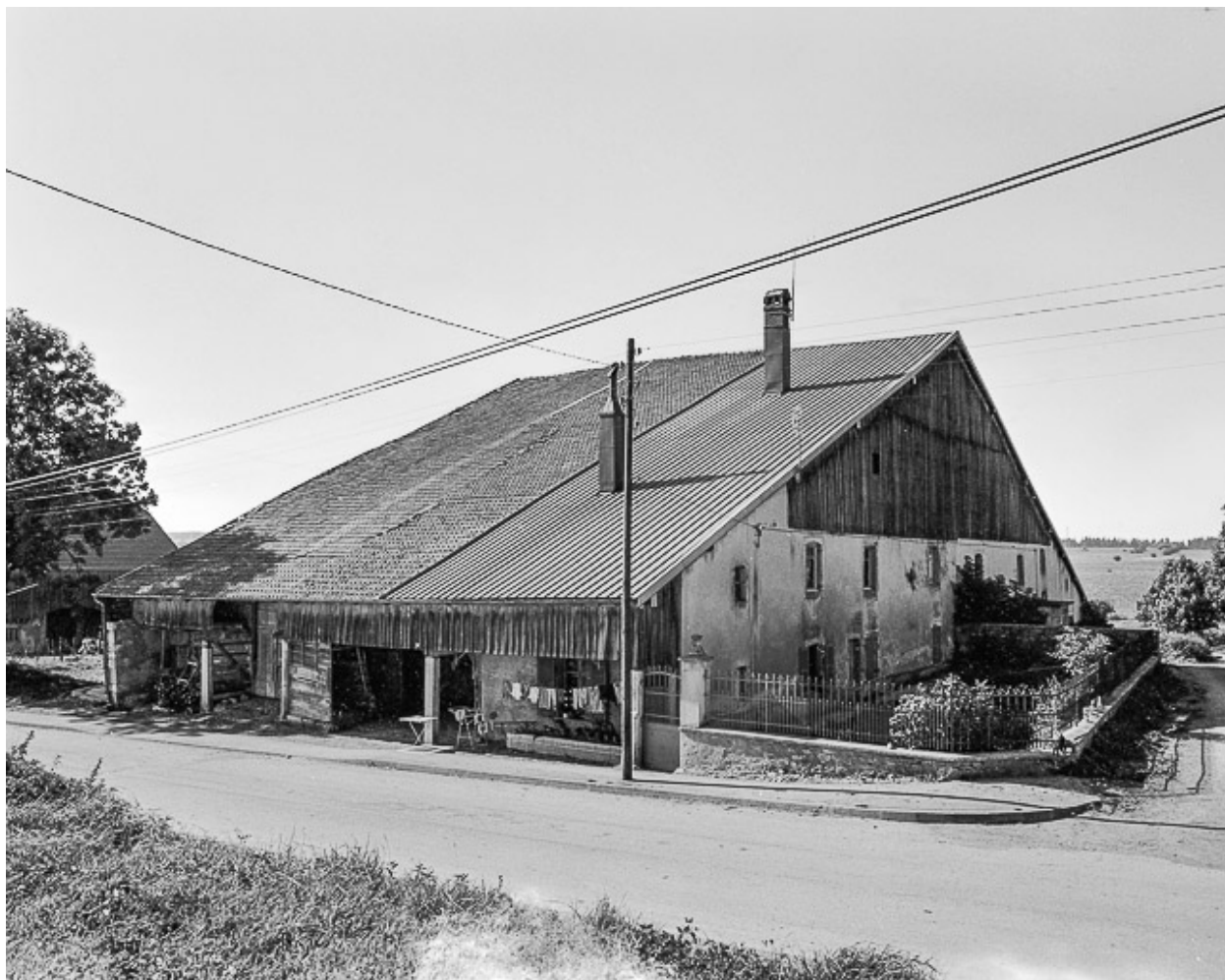
Façade antérieure et mur gouttereau sur rue.
