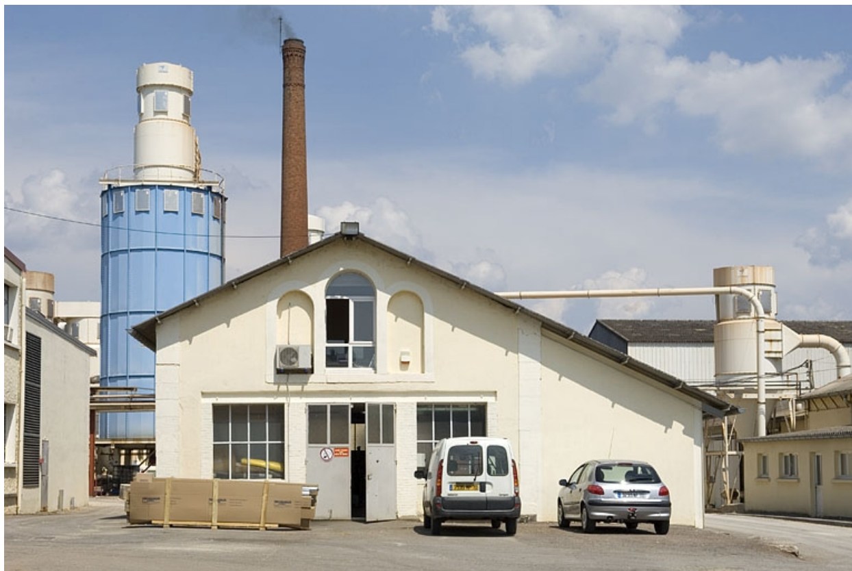
Pignon de l'atelier de réparation.
