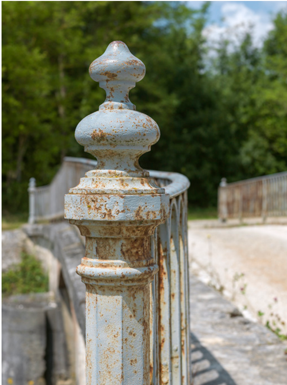
Détail du garde corps.
