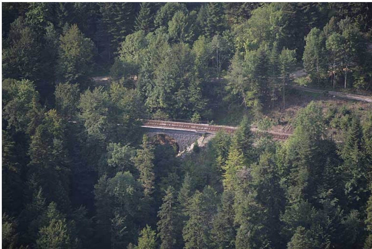
Vue aérienne du viaduc, depuis le nord.
