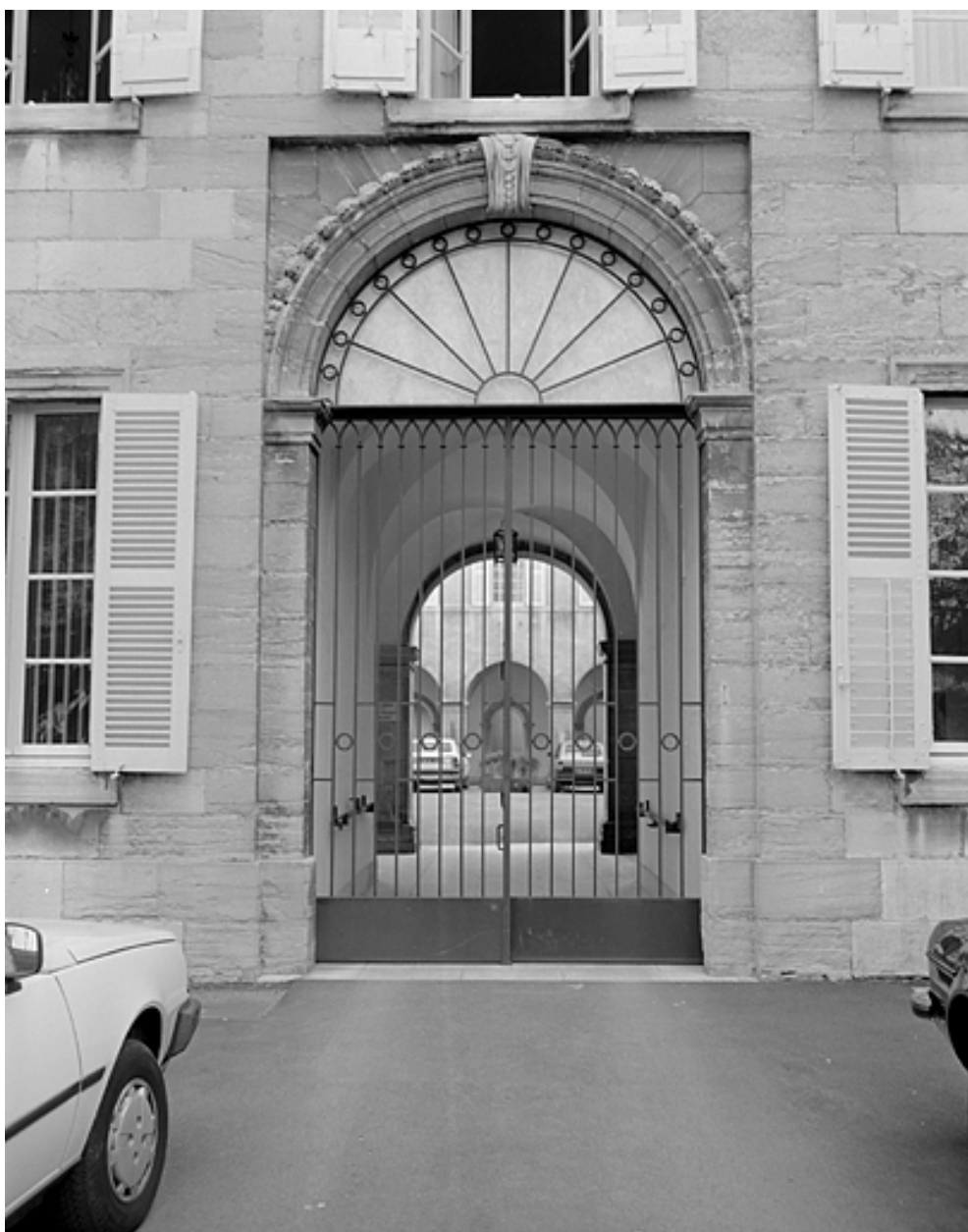
Portail d'accès au cloître.
