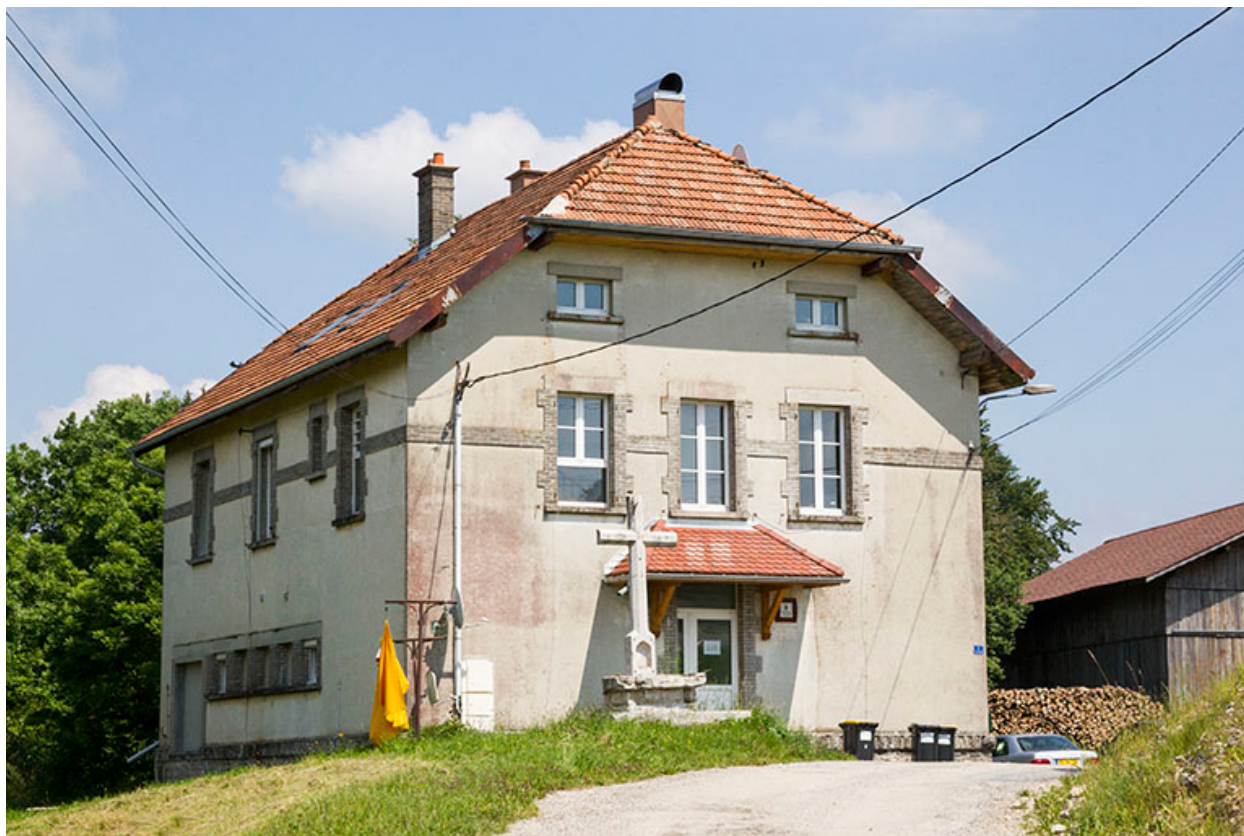
Façades antérieure et latérale gauche.
