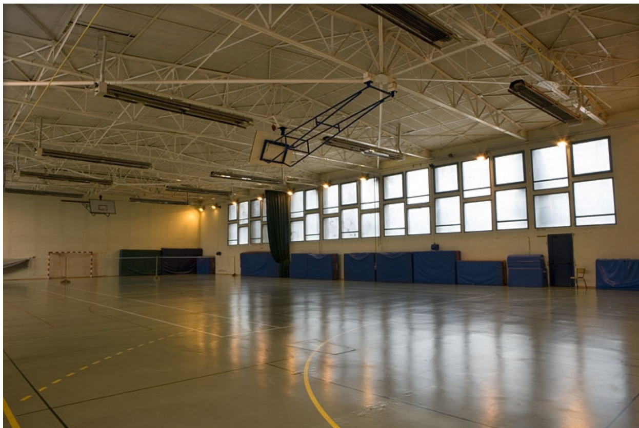
Bâtiment F1. Vue intérieure gymnase.
