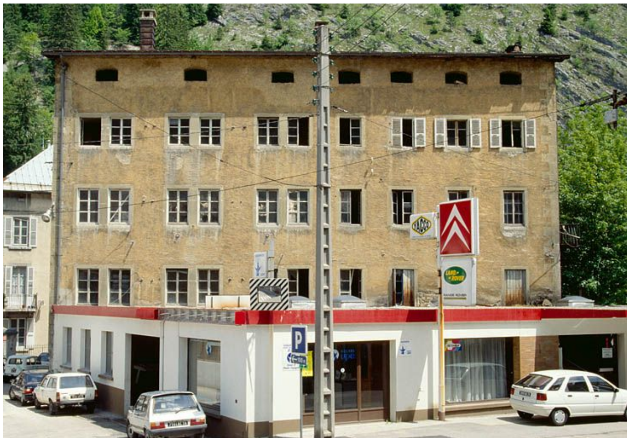
Bâtiment 6-8 rue Victor Poupin : façade antérieure.
