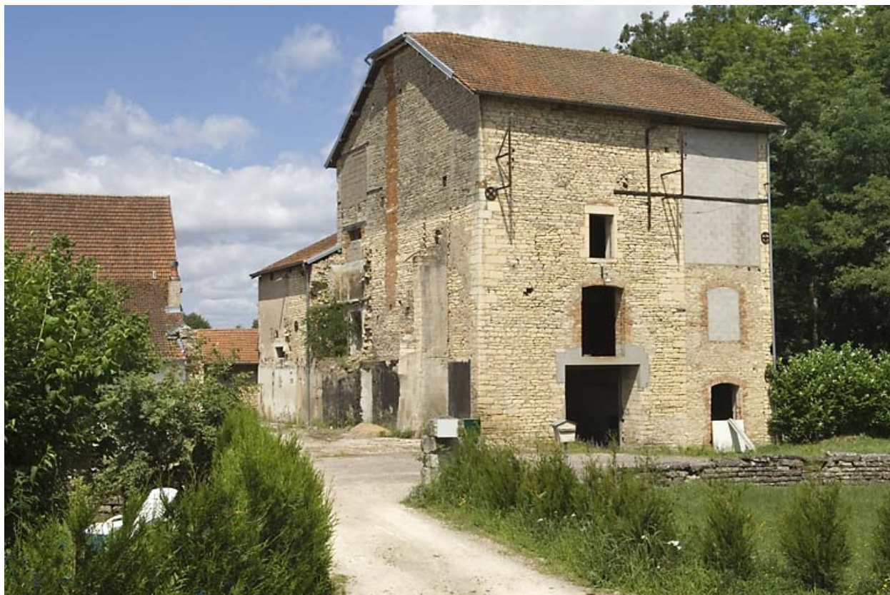
Le haut fourneau vu depuis le sud-ouest.
