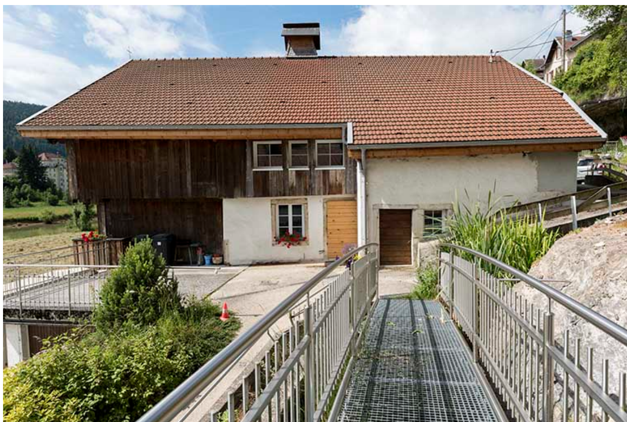
Façade latérale droite.
