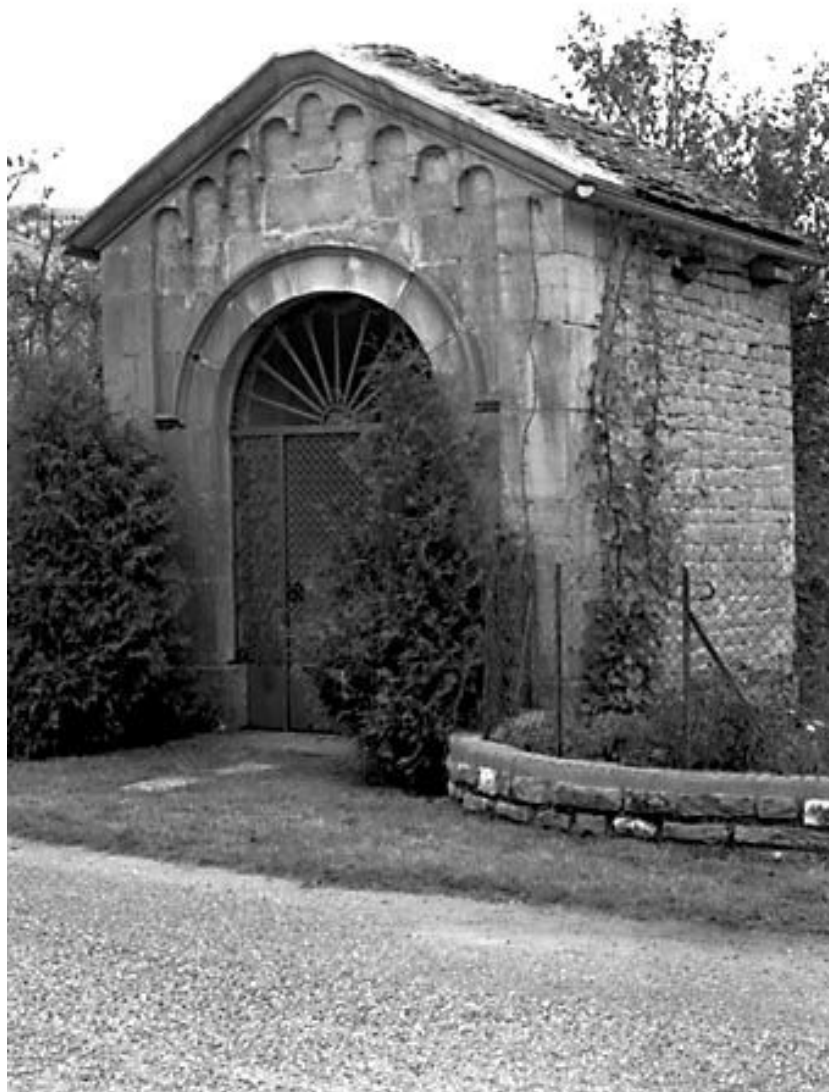
Chapelle du Dieu-de-Pitié située rue de l'Eglise.
