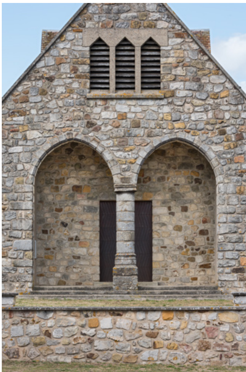
Façade antérieure, détail du porche.
