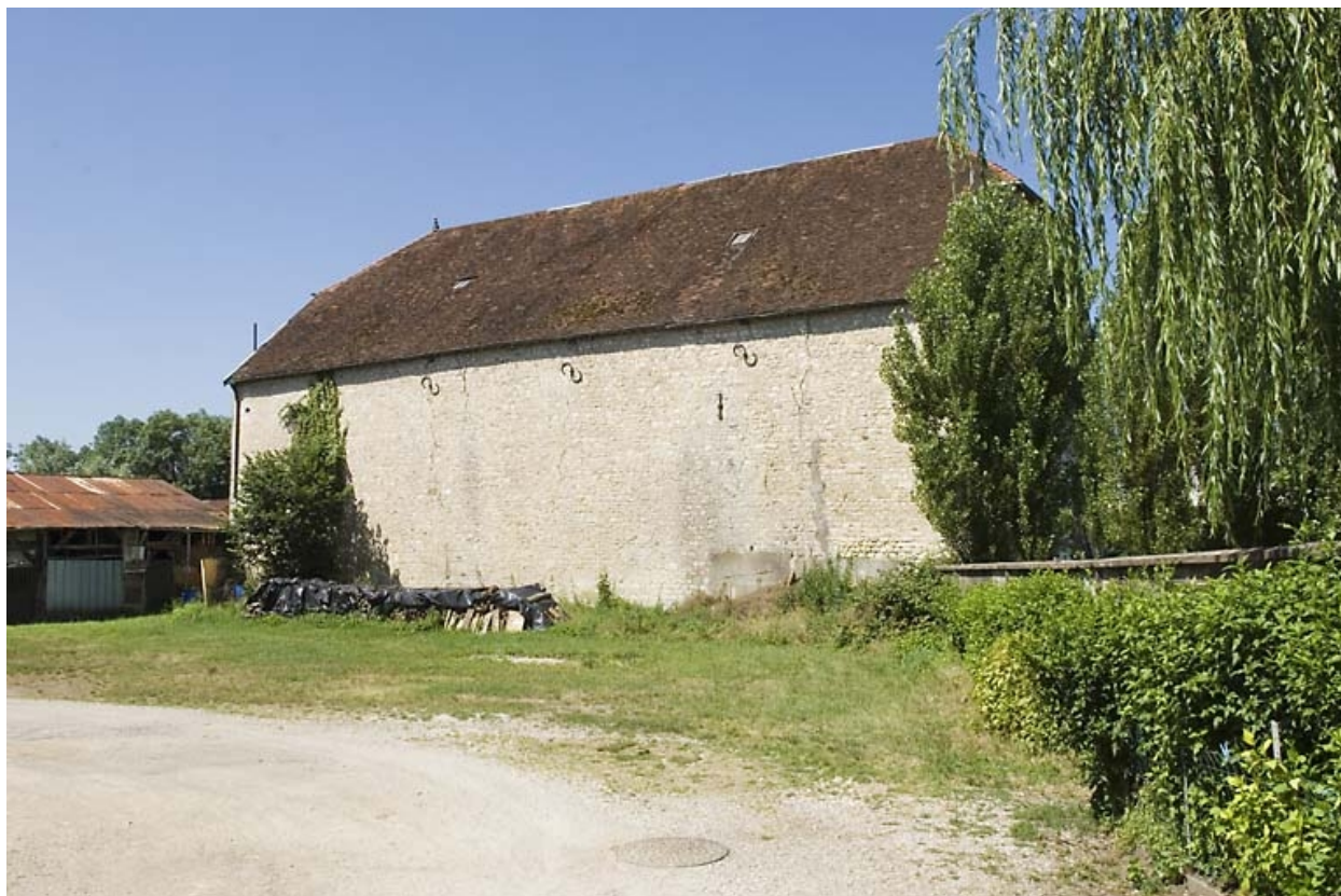
Façade est du haut fourneau.
