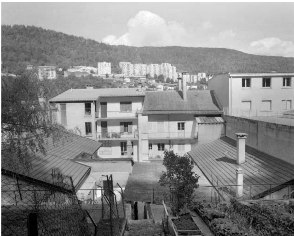
Façade postérieure des bâtiments.
