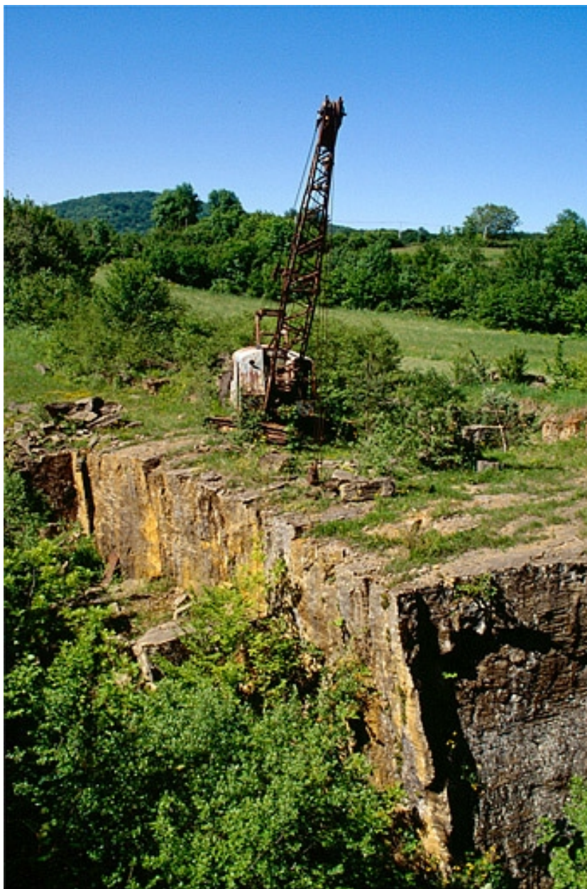
Carrière des Carrats, à Graye-et-Charnay : vue d'ensemble.
