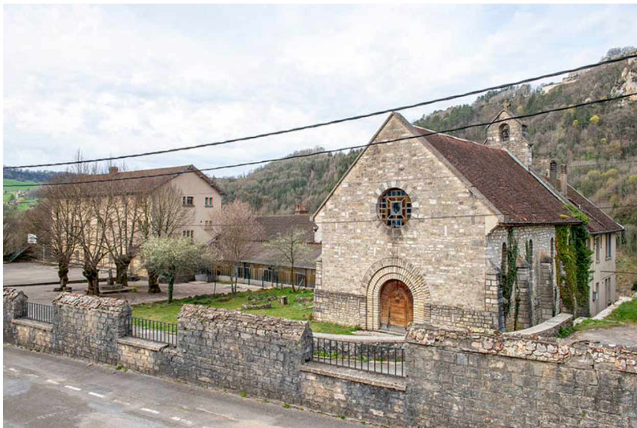
Vue de trois quarts depuis le nord-est.
