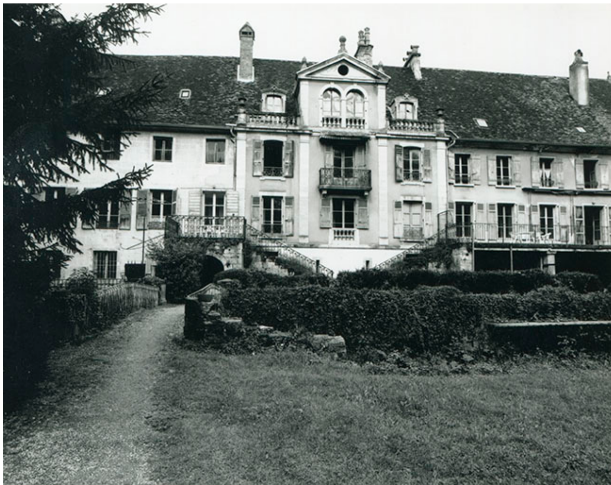
Façade sud du bâtiment conventuel, 1997.
