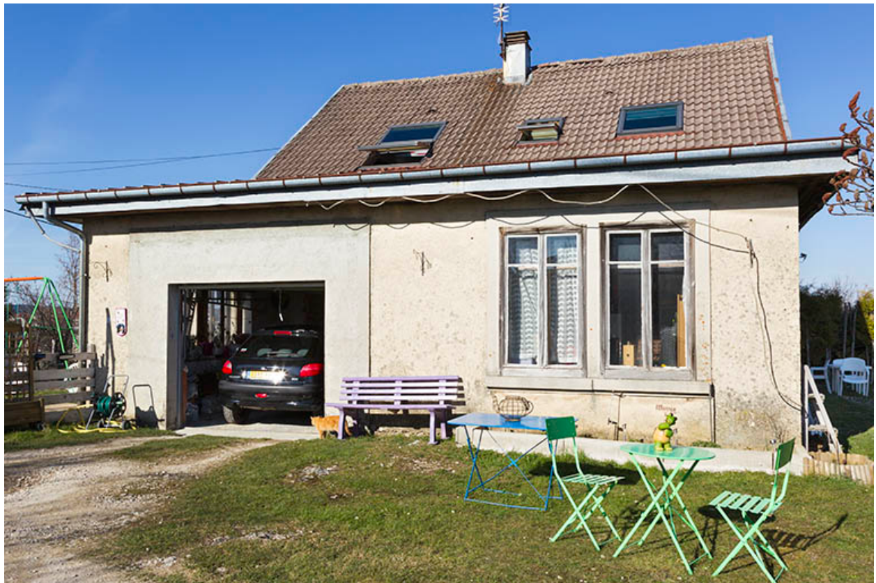
Atelier de fabrication : façade latérale gauche.
