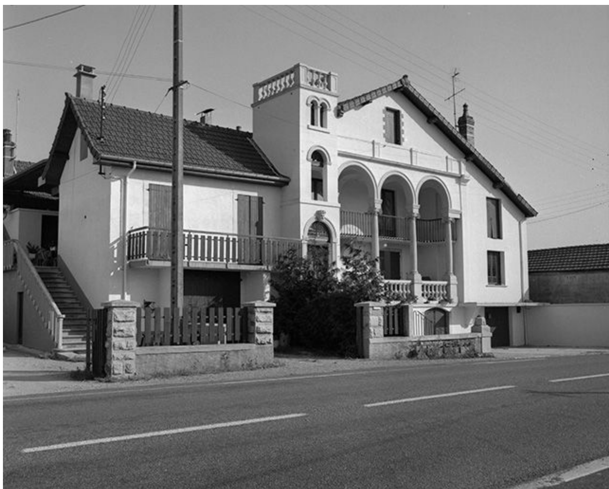
Maison située route de Lons-le-Saunier.
