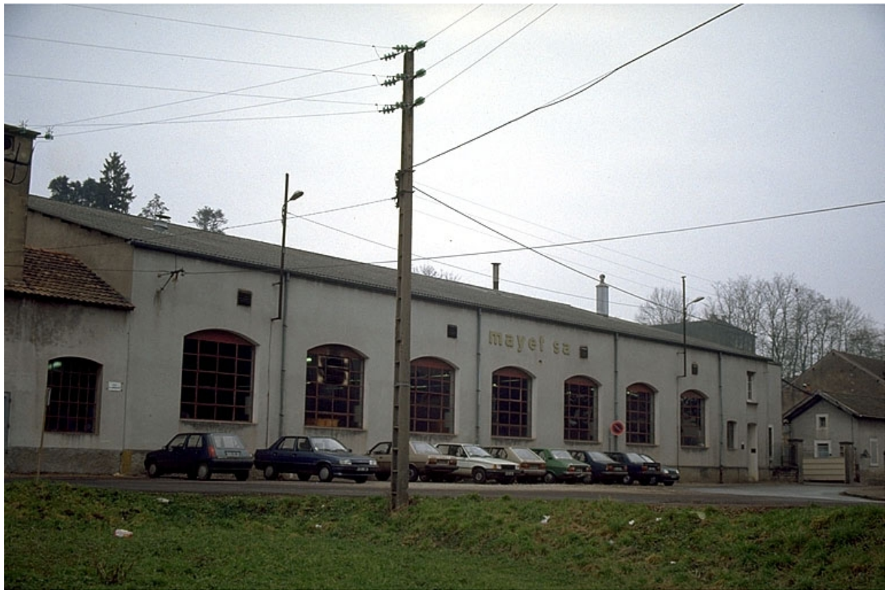
Façade antérieure de l'atelier de fabrication.
