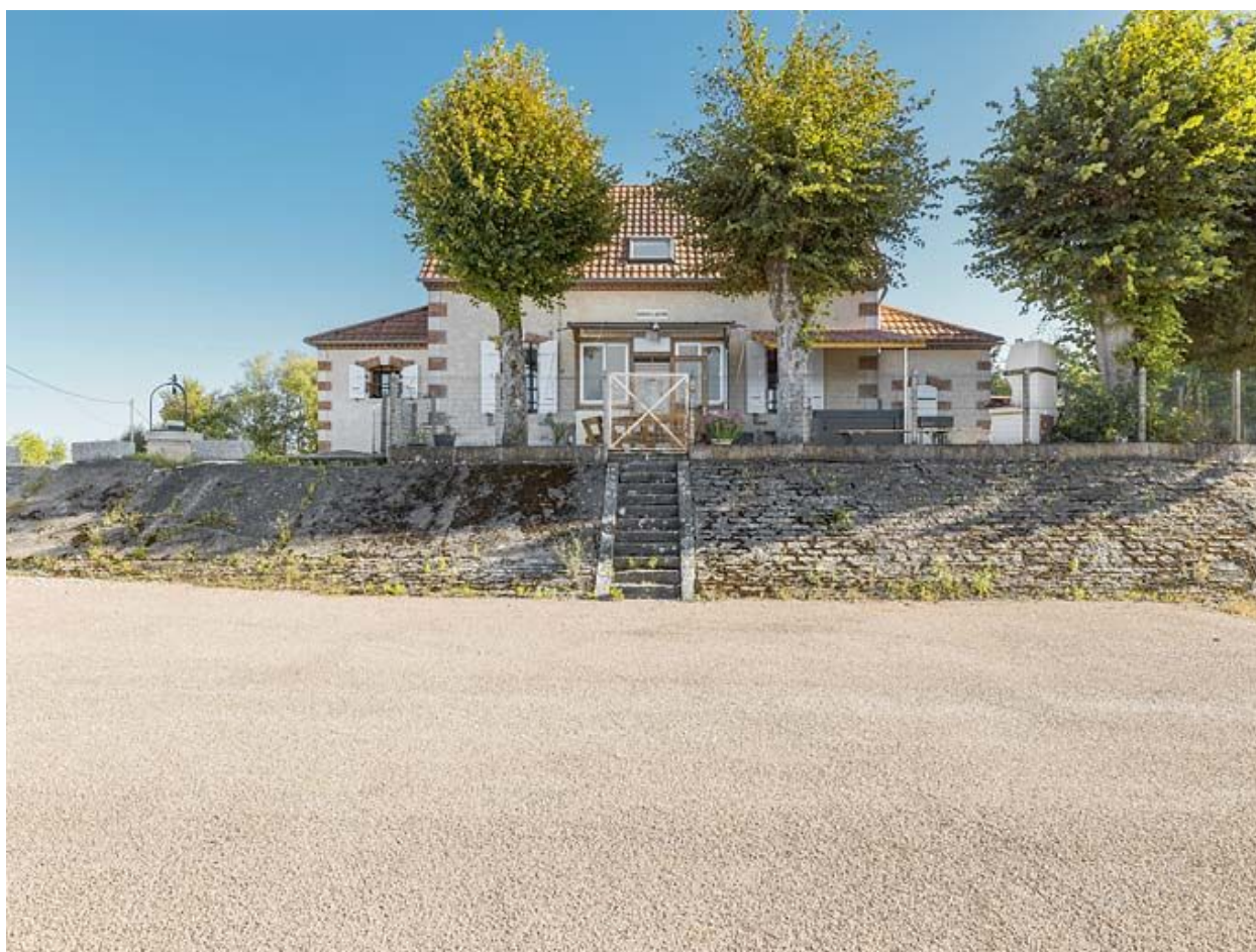
Vue d'ensemble de la maison du barragiste.
