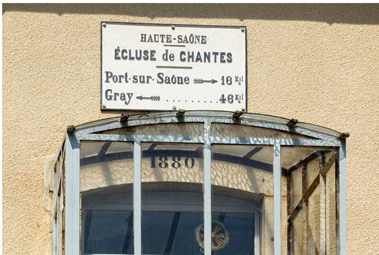
Plaque signalétique de l'écluse.
