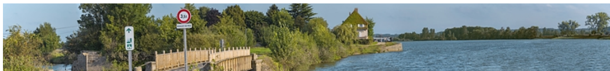
Pont et port de Grosne, rive droite.
