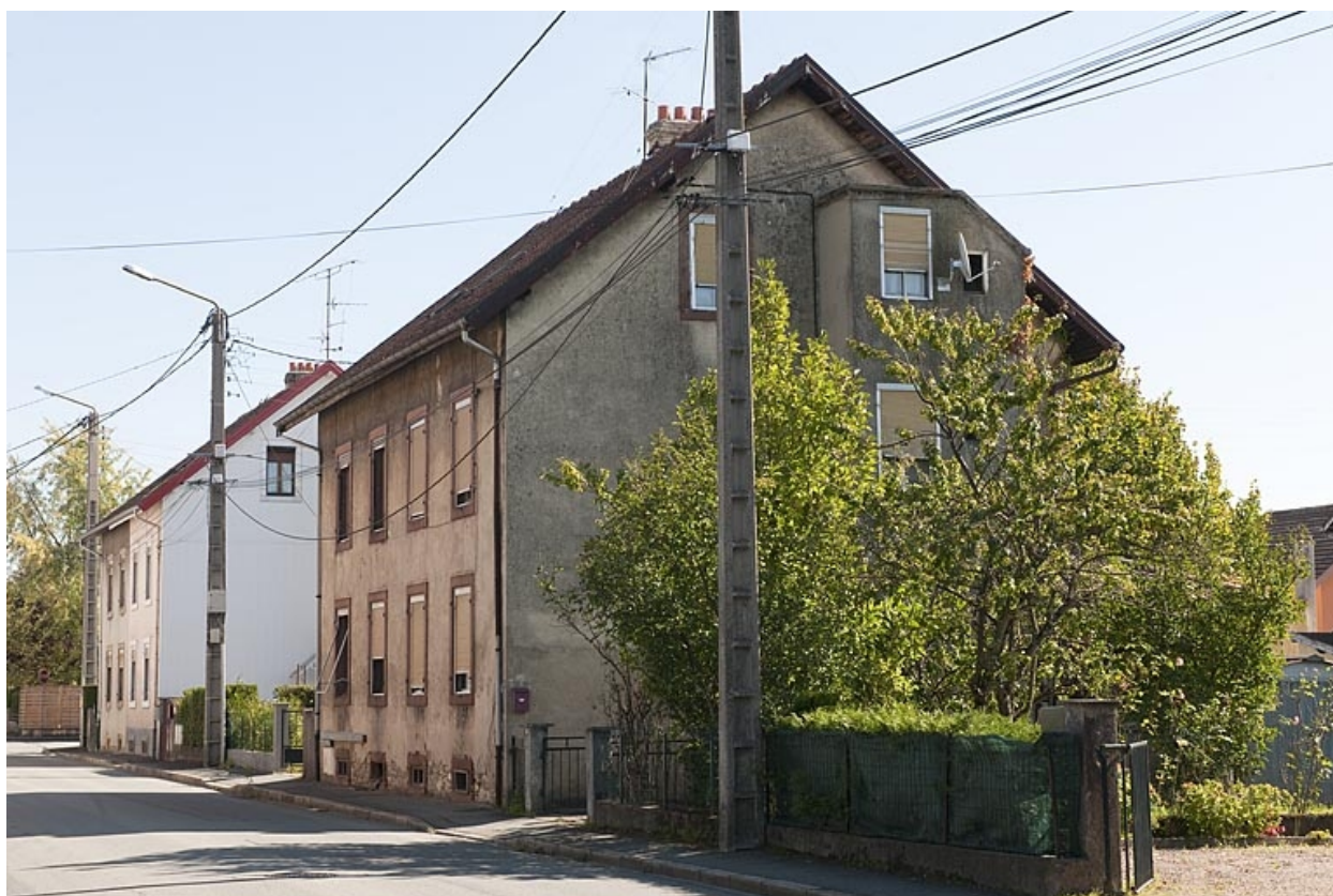
Vue de trois quarts de deux habitations.
