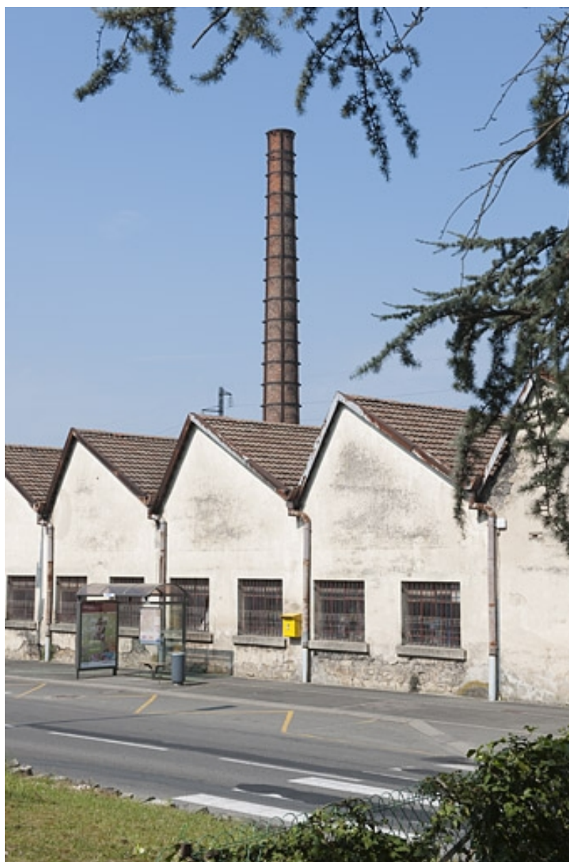
Vue rapprochée de l'atelier de laitonnerie.
