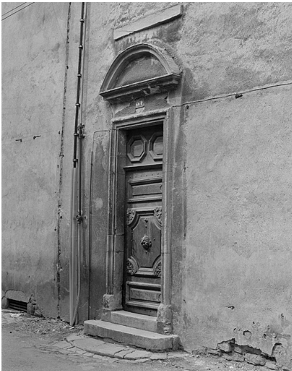
Façade latérale, porte d'entrée.
