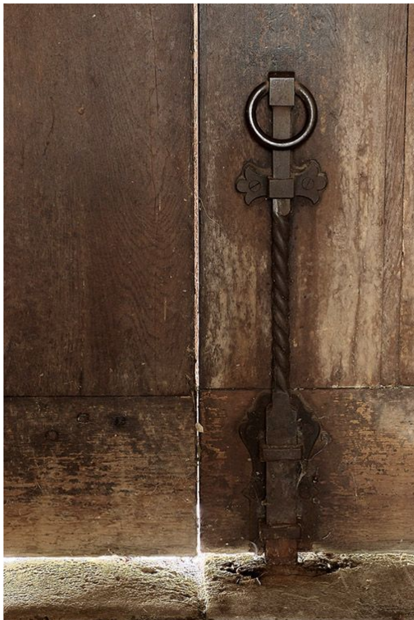
Chapelle : détail de la porte.
