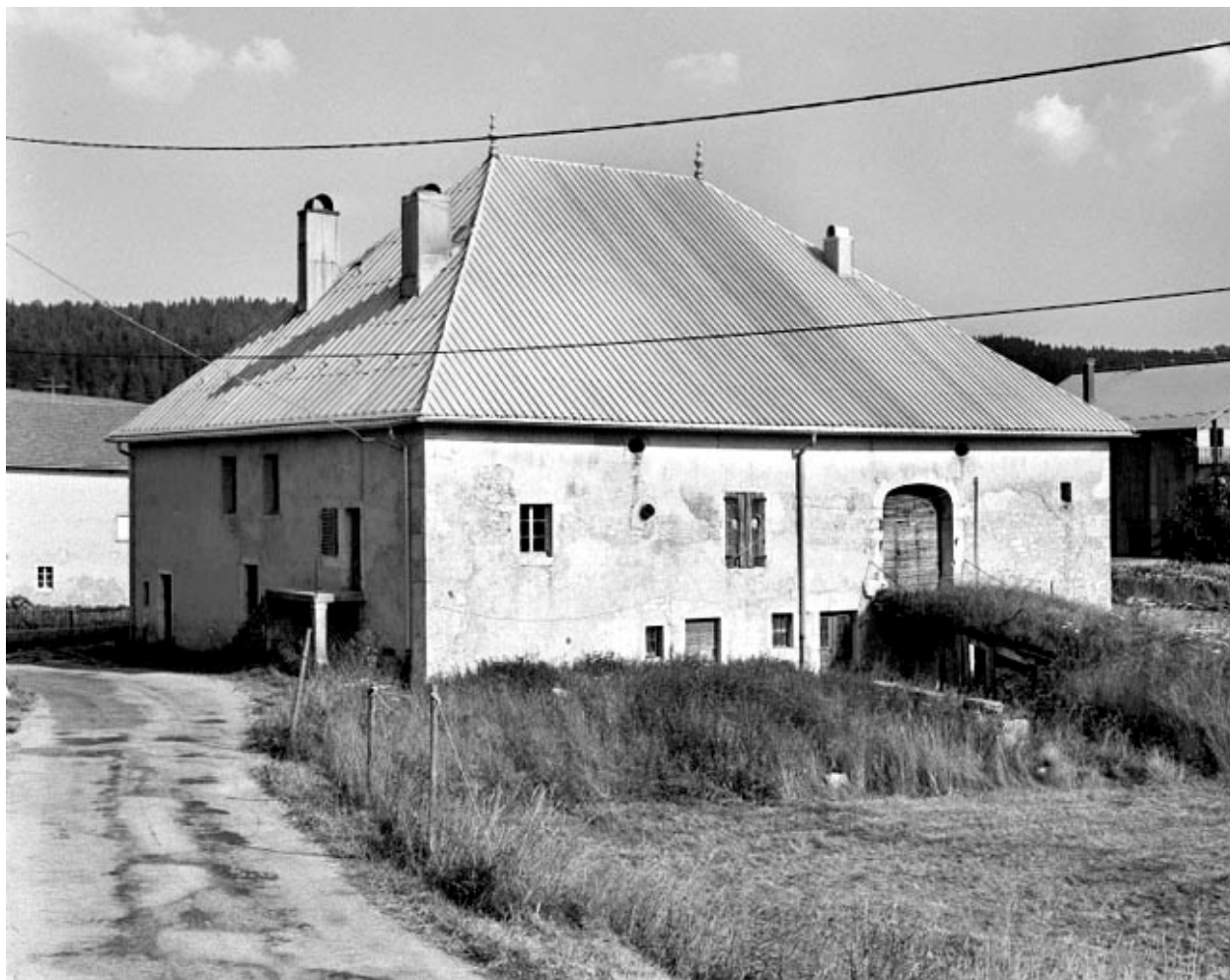
Façade postérieure avec accès aux parties agricoles.
